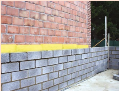
Verdubbeling van de gemene muur
