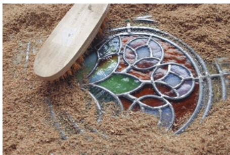
Reiniging met zaagsel om het teveel aan voegkit te verwijderen. Foto J.-M. Gdalewitch..
