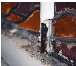
Oxidatie van de metalen omlijsting. Foto J.-M. Gdalewitch.
