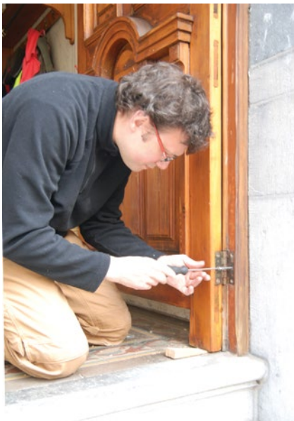
Terugplaatsing van de deur na restauratie
