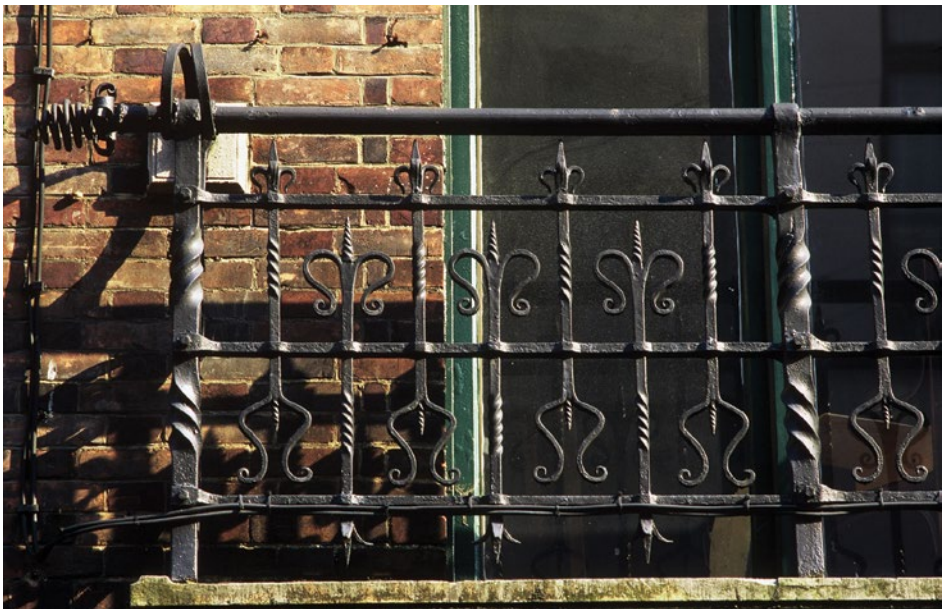
Balcon en fer forgé, 1882. Rue de Parme 30, Saint-Gilles, photo AAM.
