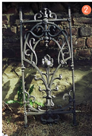
Élément décoratif en fonte remis en production par une fonderie d'aujourd'hui.
