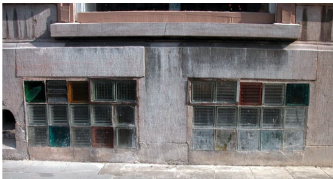
Vensters afgesloten door glazen stenen.
