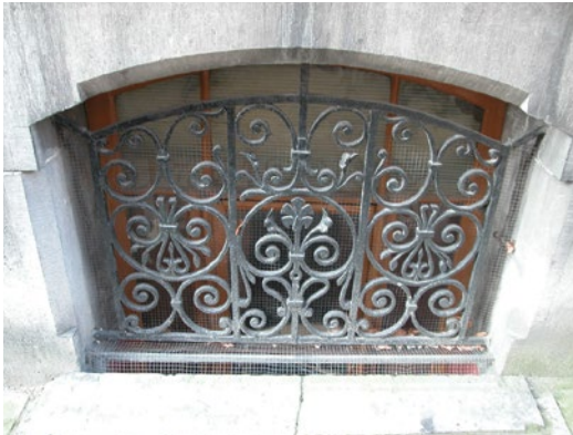
Fenêtre de cave protégée par un treillis.
