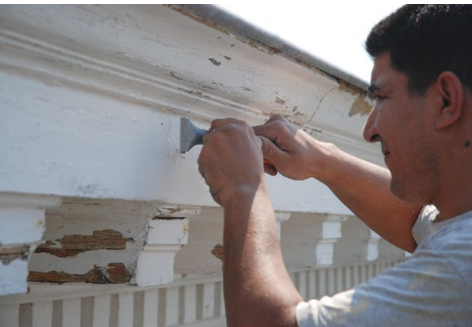
Préparation du support avant mise en peinture
