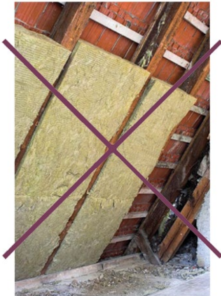
N'isolez pas une toiture par l'intérieur si elle n'a pas de sous-toiture
