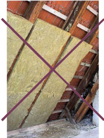
Plaats geen isolatie langs de binnenkant van uw dak indien er geen onderdak is
