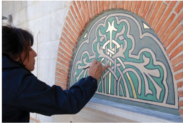
Rue Véronèse 9 à 1000 Bruxelles: restauration par la conservatrice-restauratrice Elvira Iozzi.
