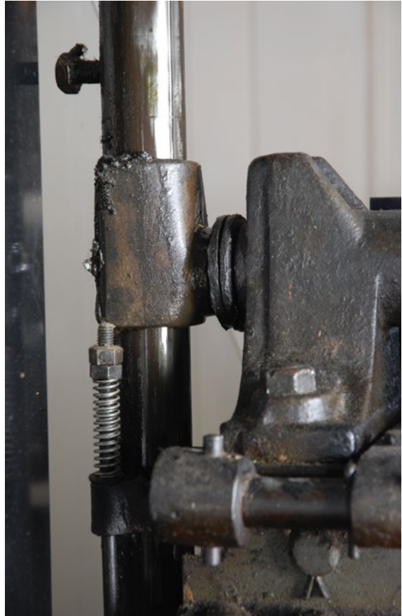
De vanginrichting: dit veiligheidssysteem, vanaf 1853 door Otis ontwikkeld, verhindert dat de liftkooi valt bij een kabelbreuk.
